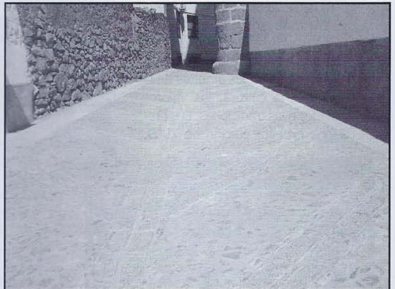
Obras en travesía calles Iglesia-Santa María. Red Patrimonia
