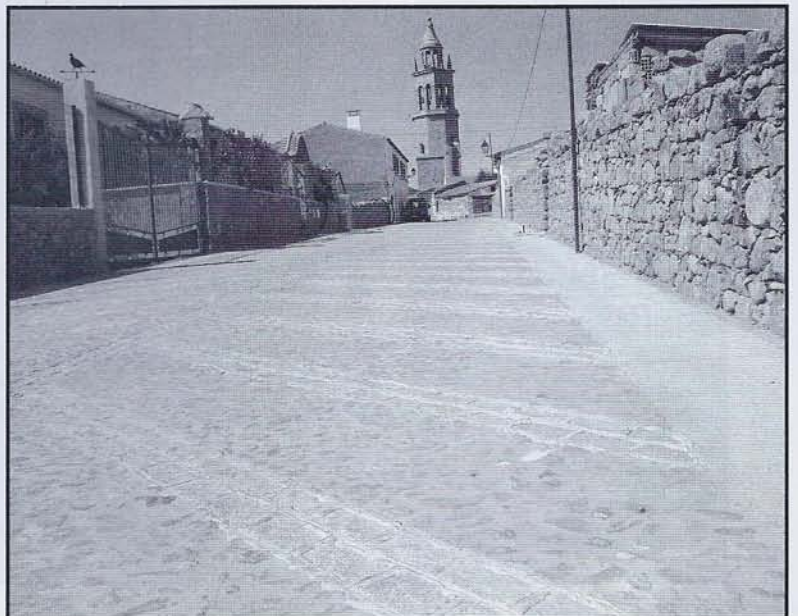
Arreglo calle Torreón. Profea
