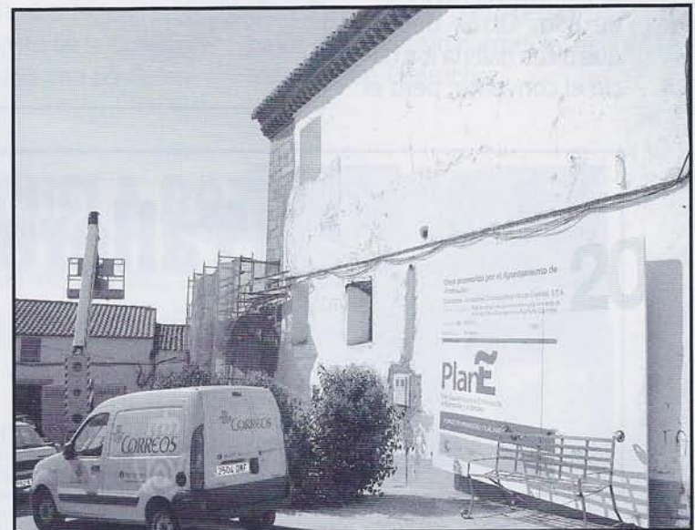
Restauración cubiertas Convento. Plan E
