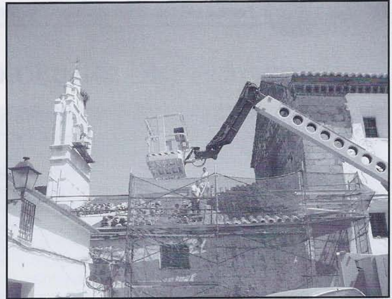
Restauración cubiertas Convento. Plan E
