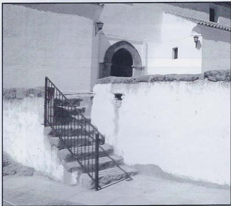
Protección acceso iglesia
