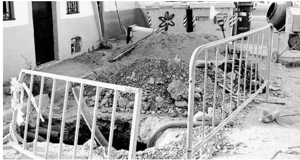
Imagen de las obras que el Ayuntamiento acomete en el Barrio de La Soledad
